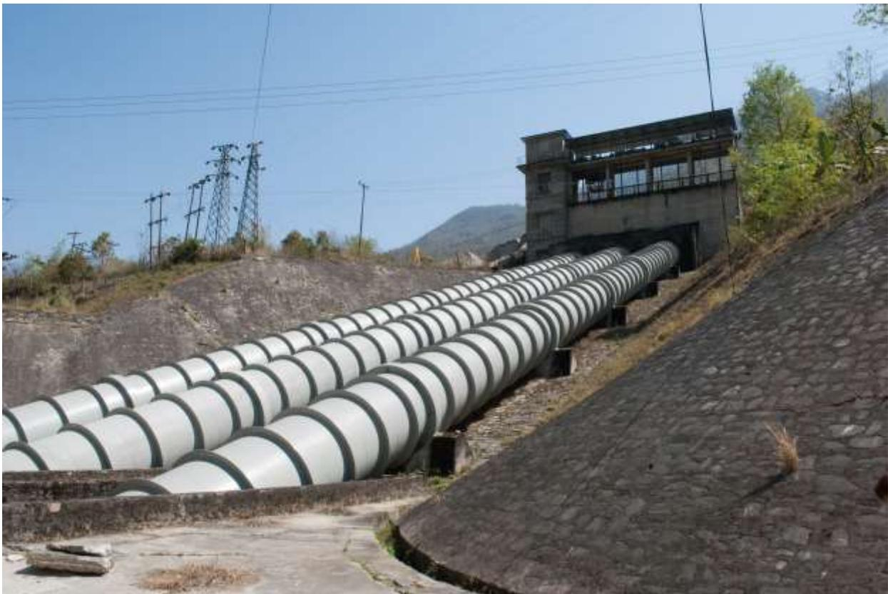
*Fig: Three penstock pipes*
